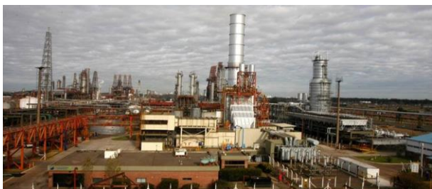
La Plata Cogeneración
