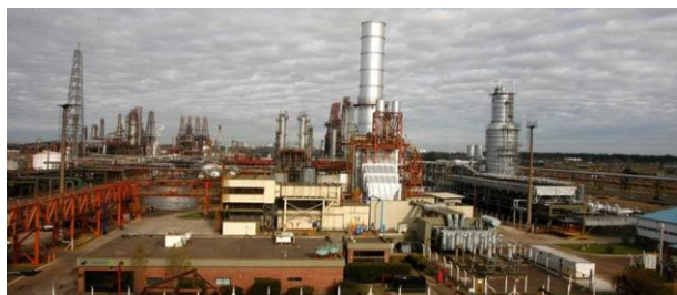
La Plata Cogeneración
